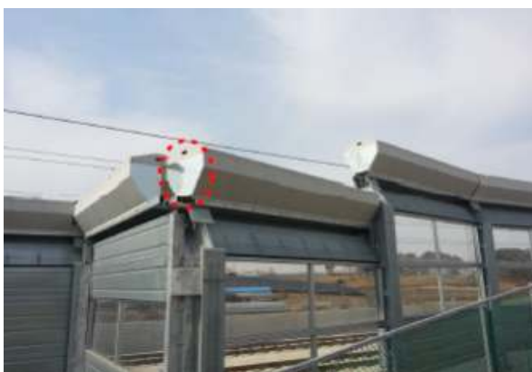
<그림 5>방음벽 상단에 설치된 소음저감장치
