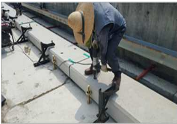
프리캐스트 콘크리트 주행로 시공
