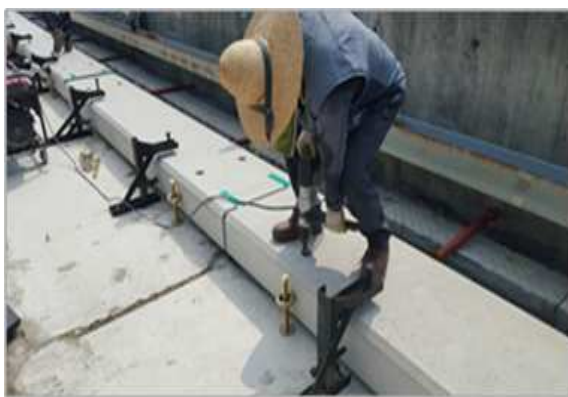
<그림2> 프리캐스트 콘크리트 주행로 시공
