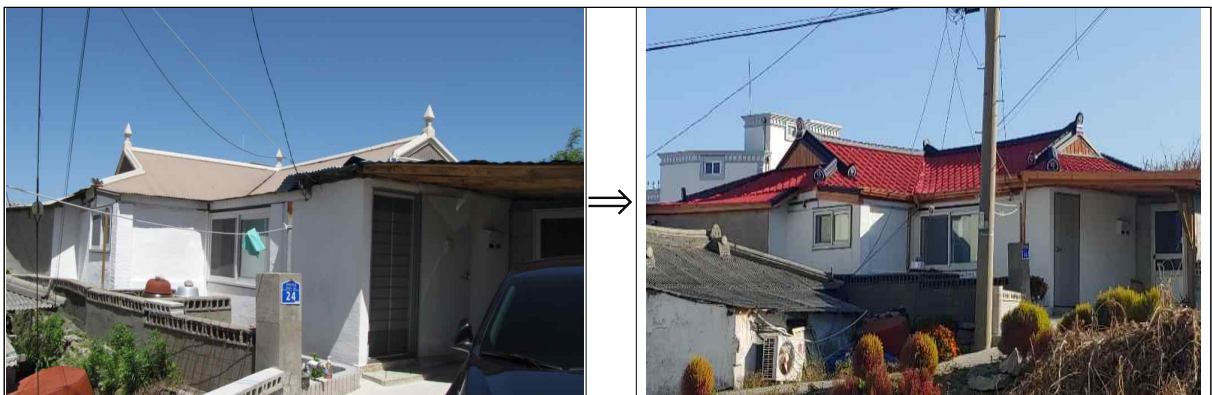
△ 노후주택 개선사업 시행 전·후(강릉 등대지구)
