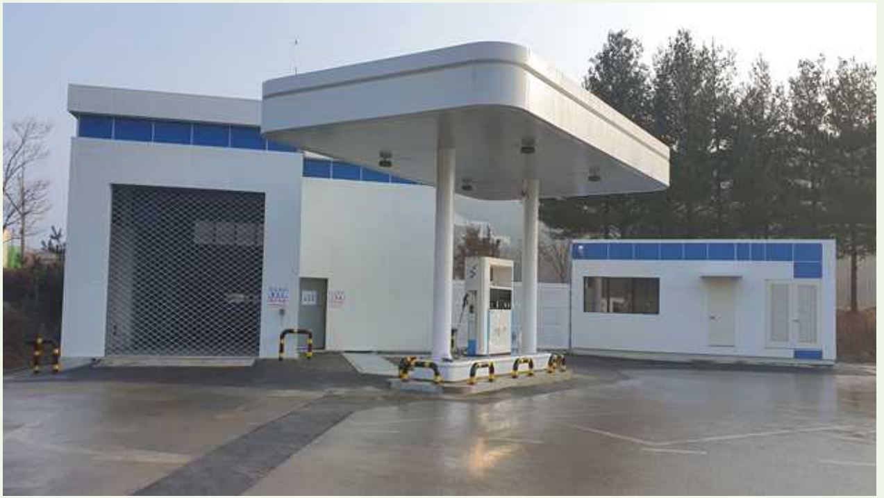
춘천휴게소(부산방향) 수소충전소 전경
