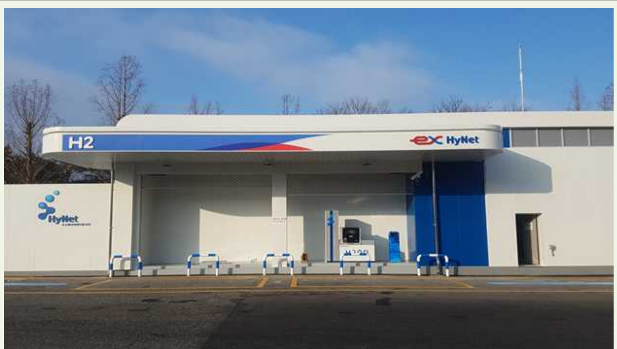
춘천휴게소(부산방향) 수소충전소 전경 2
